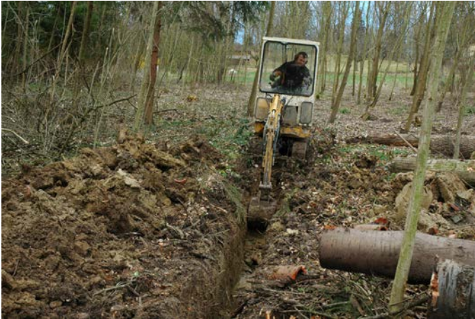
Tuyaux de drainage supprimés dans une jeune forêt. L'eau peut à nouveau s'écouler librement après arasement des berges.
