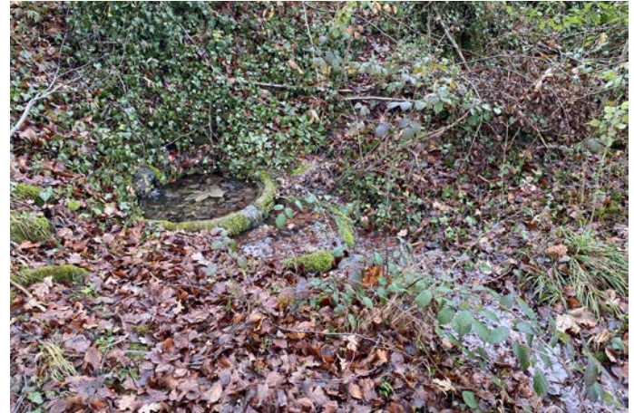
Exutoire artificiel de la nappe phréatique. La suppression de l'ouvrage en béton permet de recréer un milieu fontinal naturel
