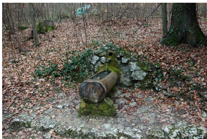
Les ruisseaux forestiers sont généralement alimentés par une source locale. Le milieu est détruit par le captage.
